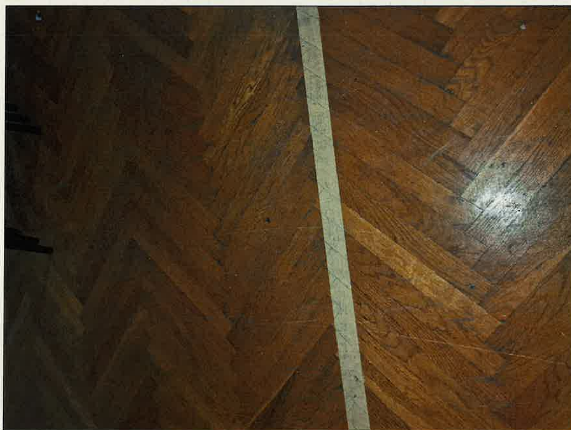
Sala D.222 - szczegół posadzki
