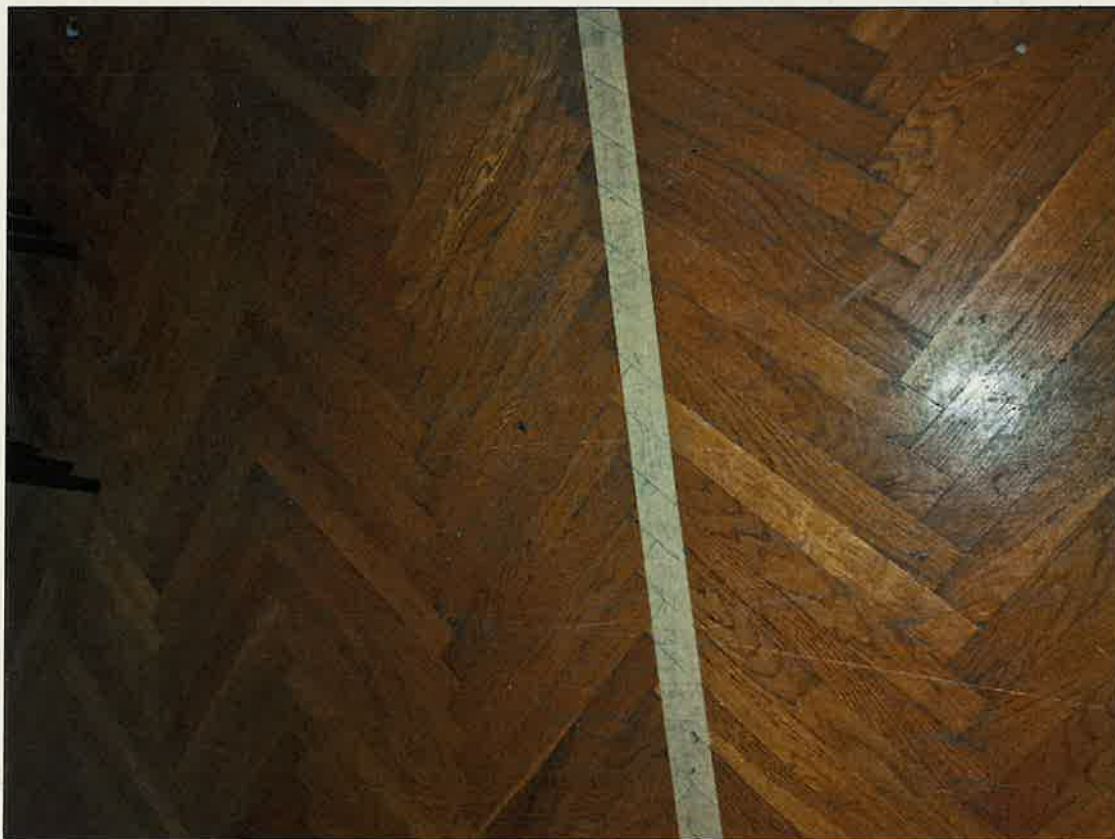
Sala D.222 – szczegół posadzki
