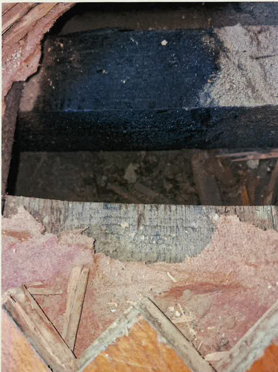
Sala D.222 – odkrywka konstrukcji podłogi, widoczny legar z drewna iglastego pokryty preparatem impregnującym, prawdopodobnie Xylamitem Popularnym , na co wskazuje ciemnobrunatna barwa elementu
